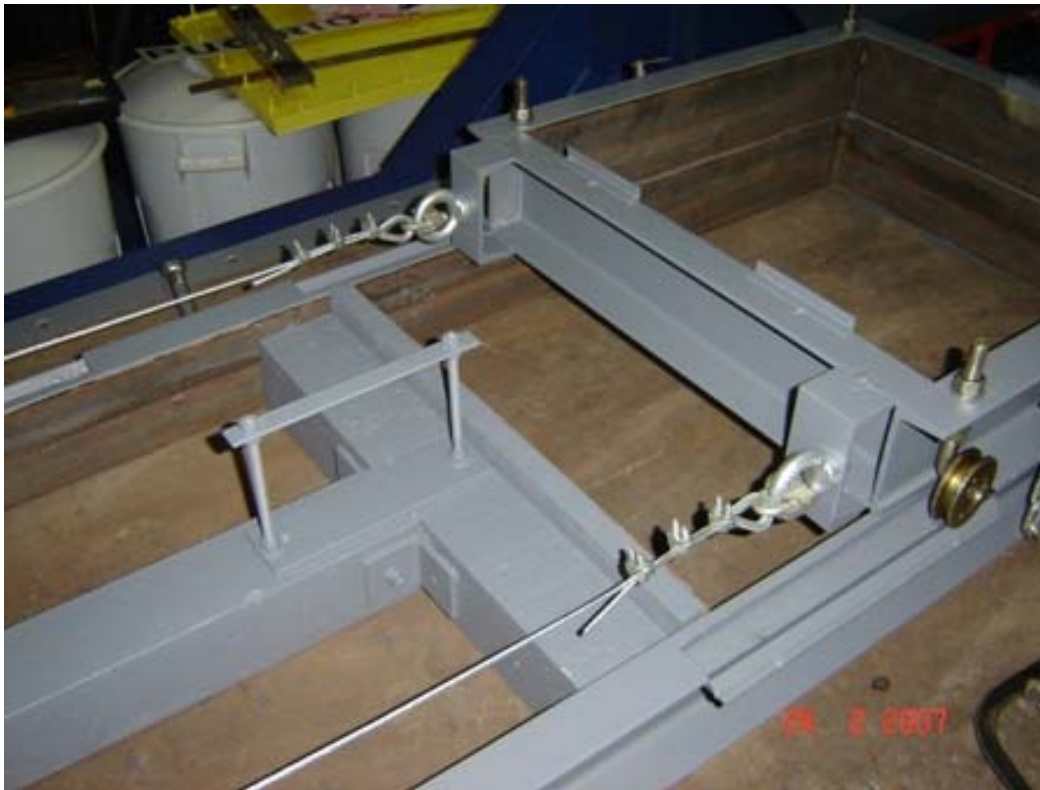
Figura 165 - Instalação dos cabos de aço nos anéis de carga da caixa superior.
