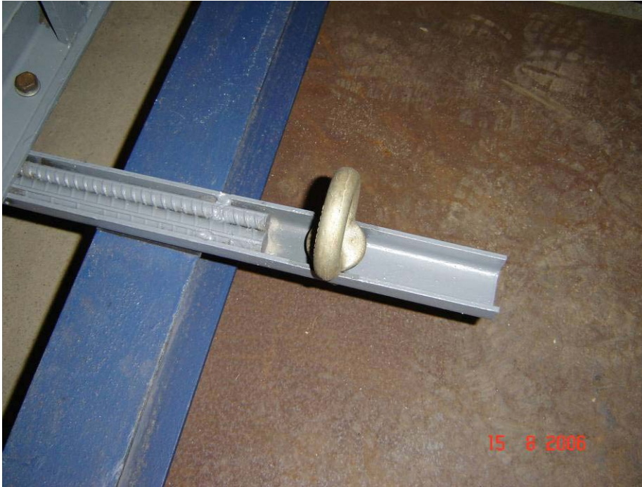
Figura 77 - Local de fixação do sistema de basculamento.
