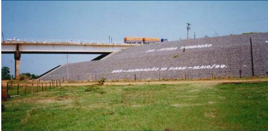
Figura 7 - Encontro de pontes.
