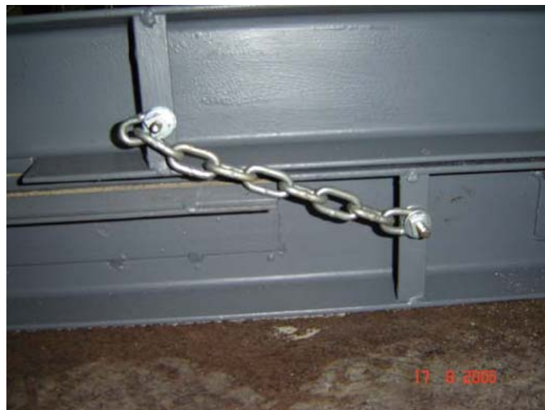
Figura 84 - Limitador de deslocamento (esticado).
