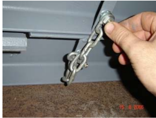
(b) Colocação do limitador.
