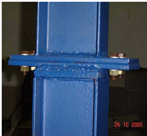
Figura 73 - Ligação do pórtico.
