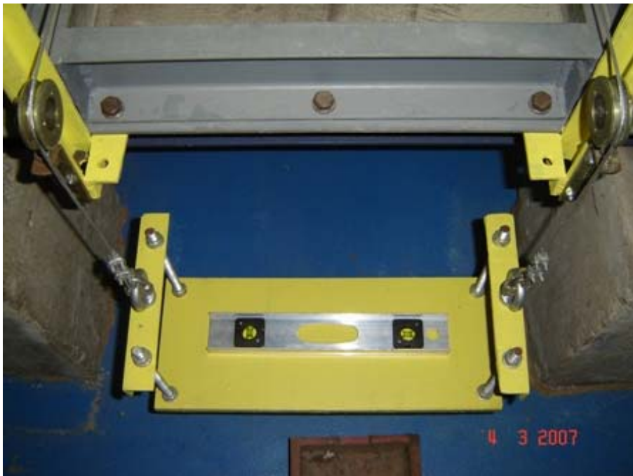
Figura 167 - Nivelamento da plataforma.
