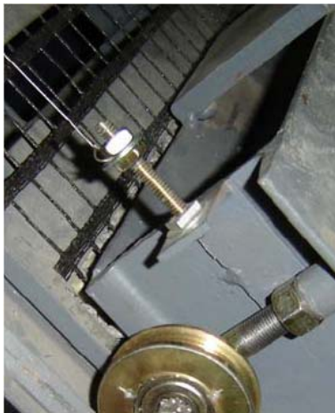
Figura 108 - Fixação do tell-tale na caixa superior.
