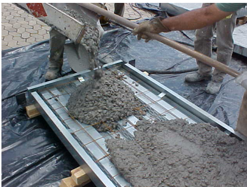
Figura C.2 - Concretagem dos protótipos
