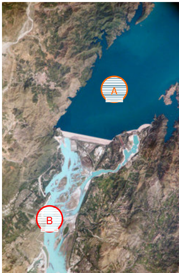
Figura 2.15 – Barragem Tarbela (Paquistão)
