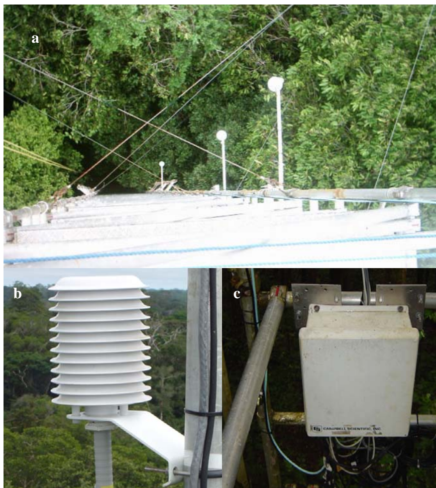
Figura 8: a- Termohigrômetros dispostos nas várias alturas (perfil da torre); b- Termohigrômetro; c- Datalogger. (Foto: U.E.C. Confalonieri).
