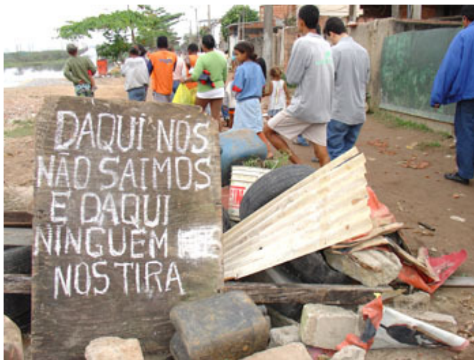
Barricada feita no dia das demolições
