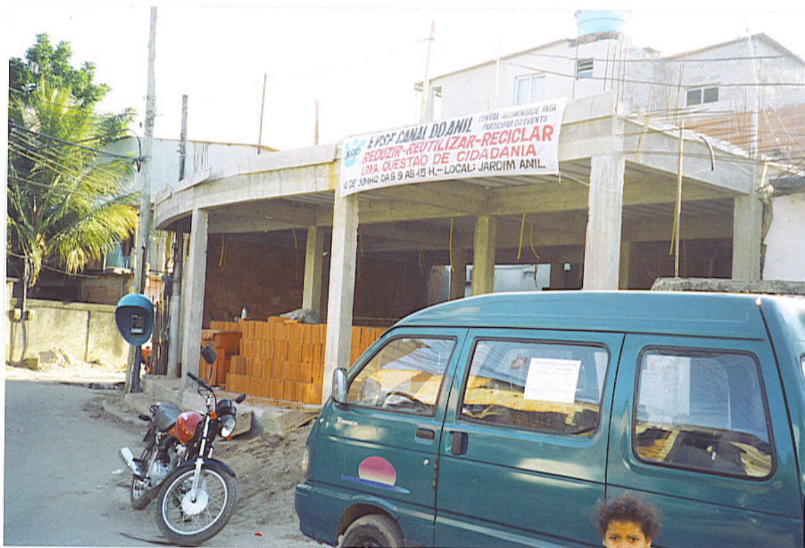
Sede da Associação de Moradores em construção
