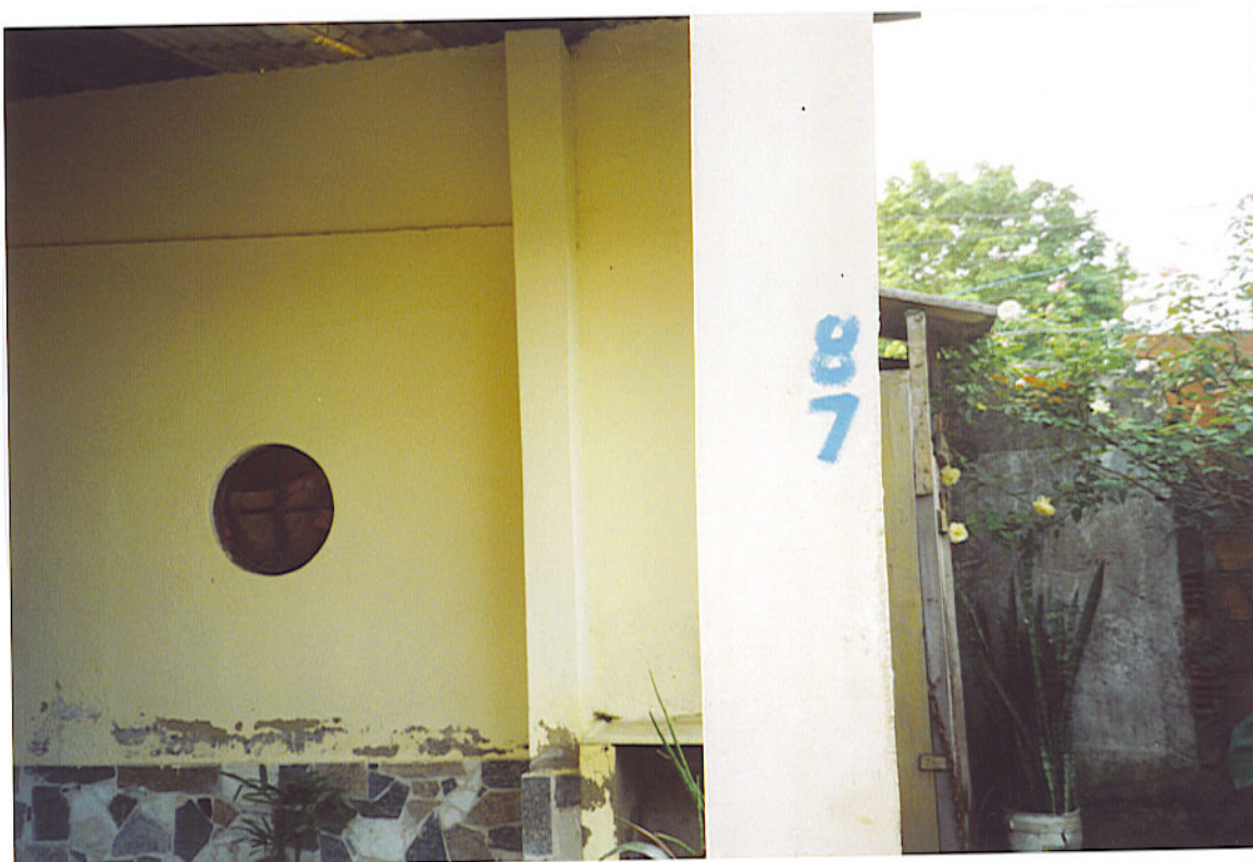
Casa marcada para ser removida
