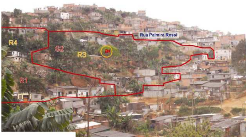
FIGURA 40 – VISTA PARCIAL DO SETOR 2 – A JUSANTE DA RUA PALMIRA ROSSI
