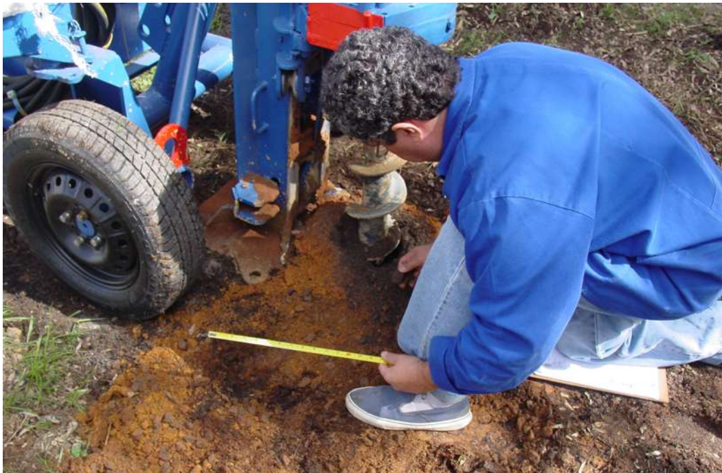
Figura 5.5 – Sondagem sendo realizada
