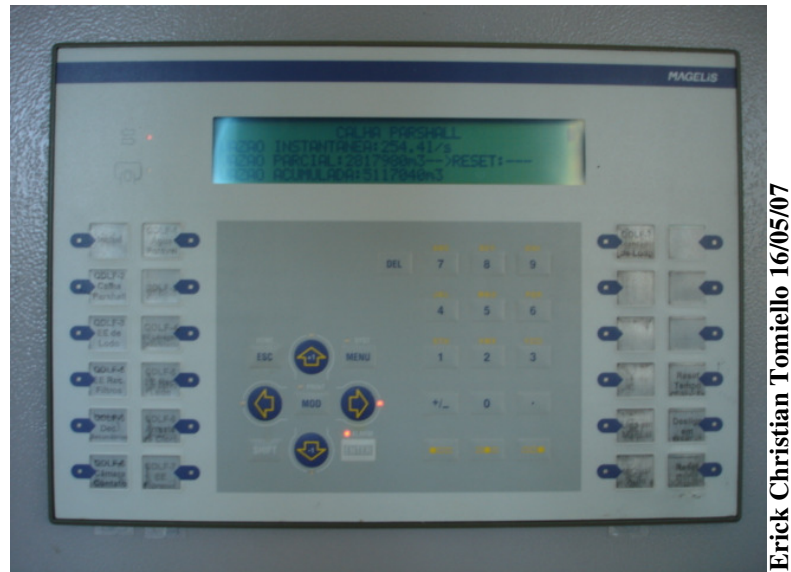
Figura 5.9 – Painel digital do equipamento para medição de vazões – ETE 02 Sul
