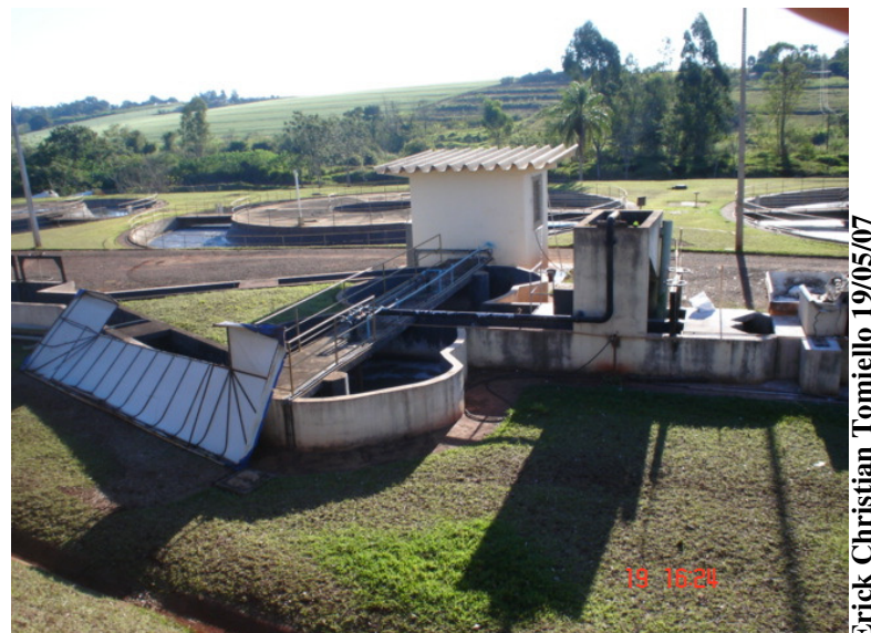
Figura 5.4 – Desarenador Ciclônico com remoção mecânica de areia – ETE 01 Norte
