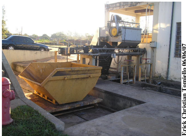
Figura 8.2 – Gradeamento grosseiro e mecanizado da ETE Pinhalzinho
