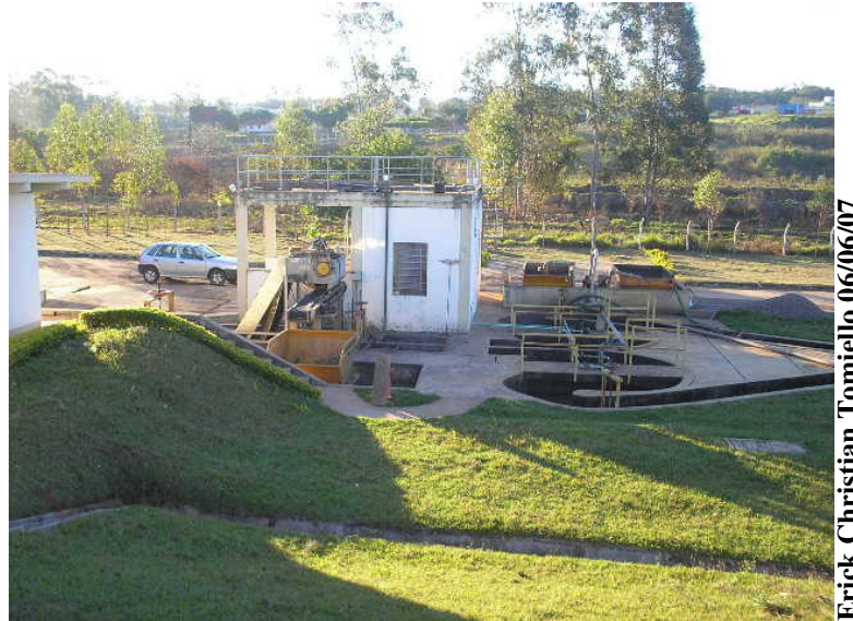
Figura 8.3 – Desarenador Ciclônico com remoção mecânica de areia da ETE Pinhalzinho
