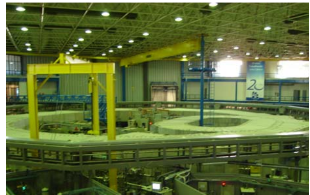
Figura 3.16: vista do anel de armazenamento do LNLS
