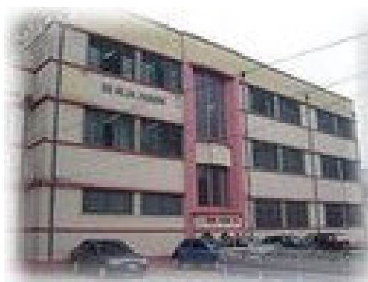
Figura 23 - Fachada da UE_4
