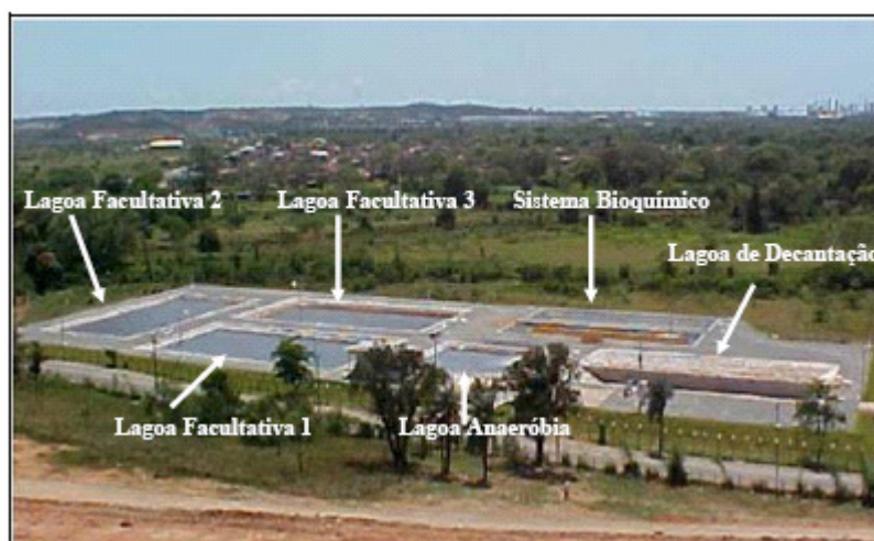
Figura 2.2 - Estação de Tratamento de Lixiviado – ETC
