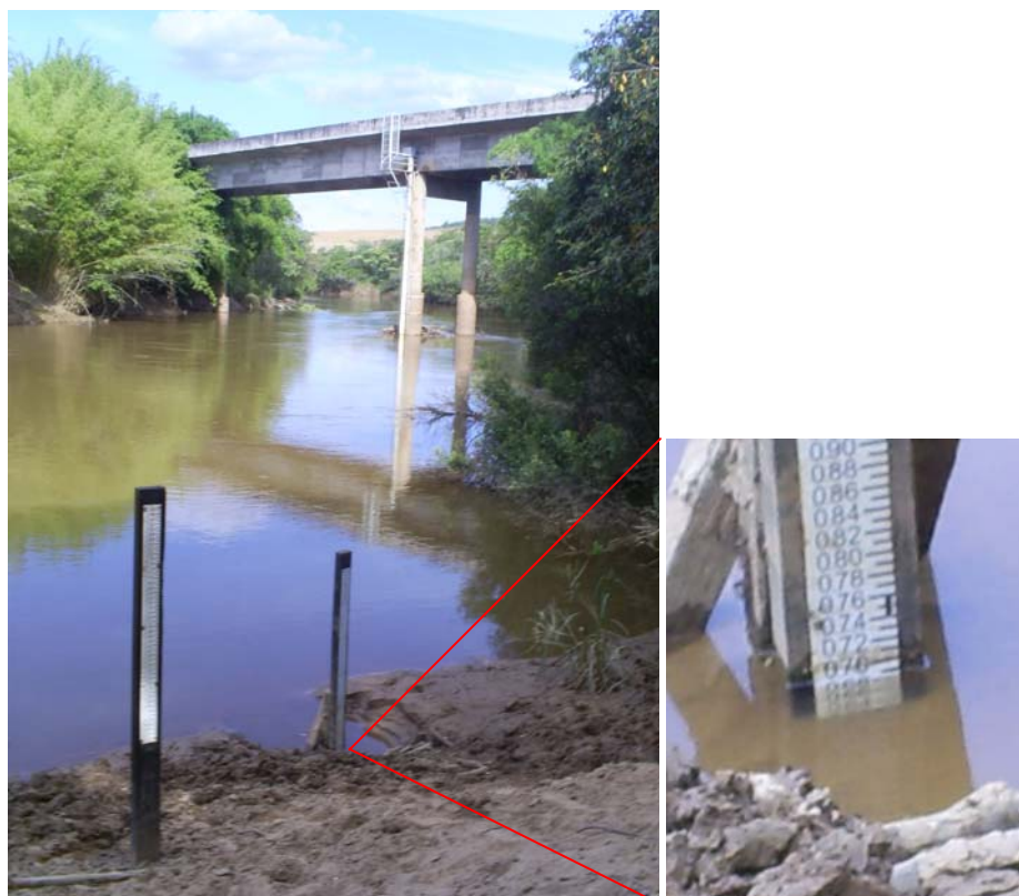
FIGURA 12. Posto fluviométrico de Madre de Deus de Minas, que dispõem de linígrafo (instalado no pilar da ponte) e régua linimétrica, IGAM.
