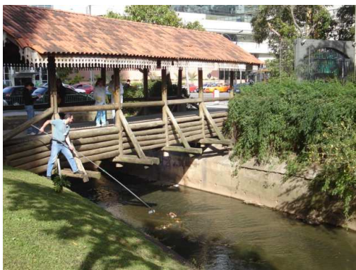
RB8 – montante da canalização
