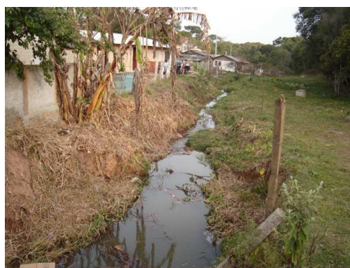
RB3 – montante da ocupação irregular.
