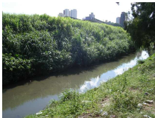
RB9 – jusante da canalização
