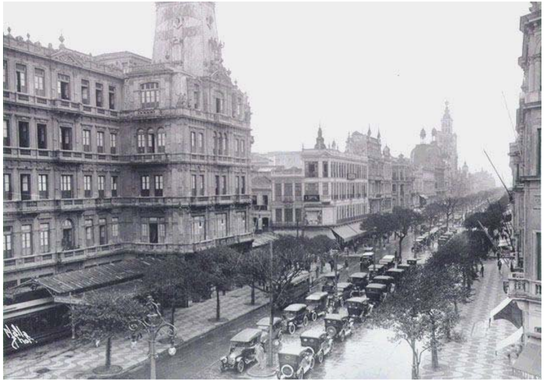
Fig. 5 Avenida Central - Rio de Janeiro
