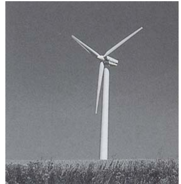
Figura 4.2.3 – turbina eólica que proporciona abastecimento de energia em uma área de serviço na Dinamarca. Fonte: Gauzin-Müller (2003, p. 103)
