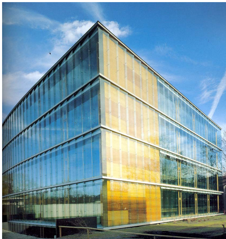
Figura 4.3,5 – As quatro fachadas estão revestidas por uma dupla pele de vidro. Fonte: Gauzin-Müller (2003, p.193)
