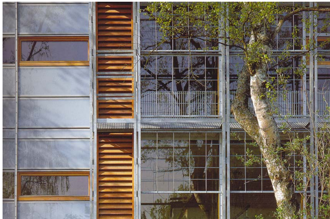
Figura 4.3.4 – Studio, Munique, arquiteto Thomas Herzog. Fonte: Schittich (2003, p.25)
