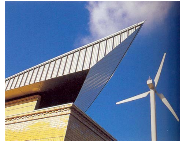
Figura 4.2.4 – turbina eólica produz parte da energia consumida no edifício do Liceu de Calais. Fonte: Gauzin-Müller (2003, p. 198)
