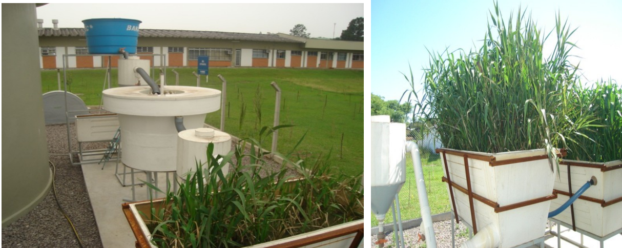
Figura 10. Vista panorâmica da unidade piloto implantada na UNISC com detalhe do wetland
