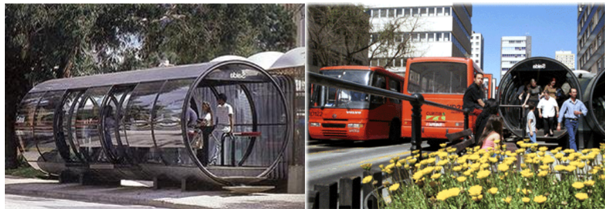
FIG. 2.1 Estação Tubo – Curitiba
