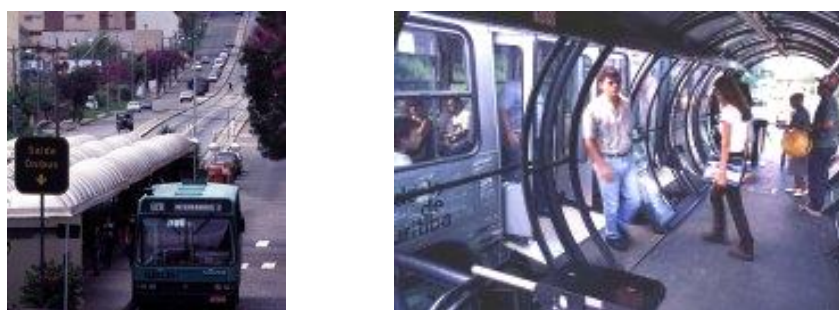
FIG. 2.2 Terminais e Estações Tubo
