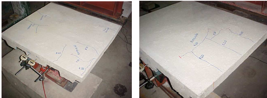
Figura 5.82 – Fissuras de retração
