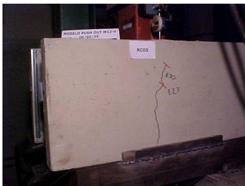
Figura 4.29 – Fissuras da laje do modelo M12-4
