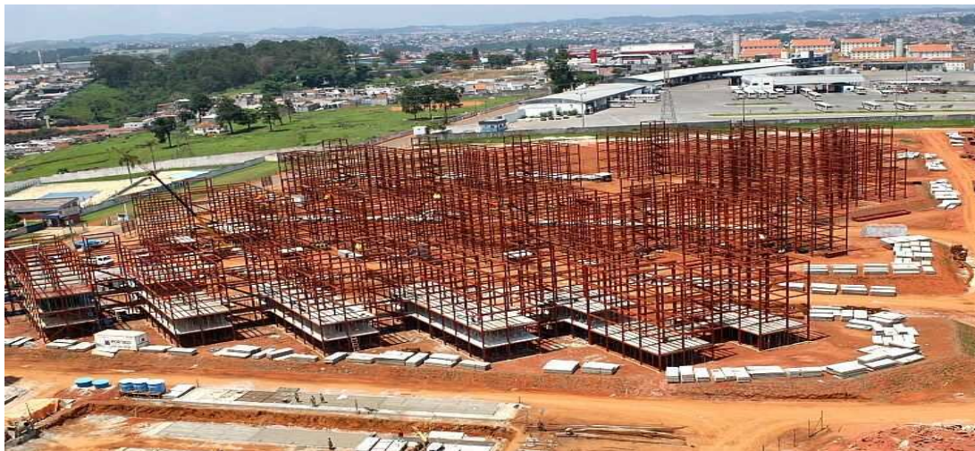
(b) Vista geral de 94 prédios na fase de construção.
