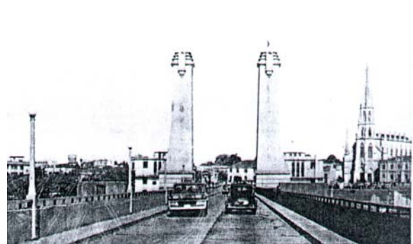
Imagem 26: Ponte já aberta ao tráfego em 1945. Fonte: Arquivo municipal
