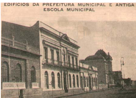
Imagem 13: Prefeitura Municipal. Construção de 1901. Arq. Construtor Antonio Parga. Fonte: Arquivo Municipal
