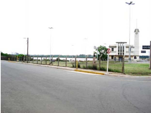
Imagem 72: Acesso central à ponte foi cercado. Fonte: Pesquisa de campo da autora.
