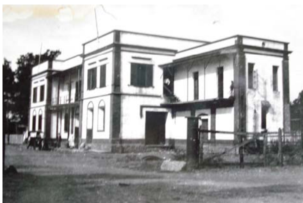
Imagem 17: Primeiro prédio da Estação Férrea em Uruguaiana. Final séc. XIX. Fonte: Arquivo Municipal.
