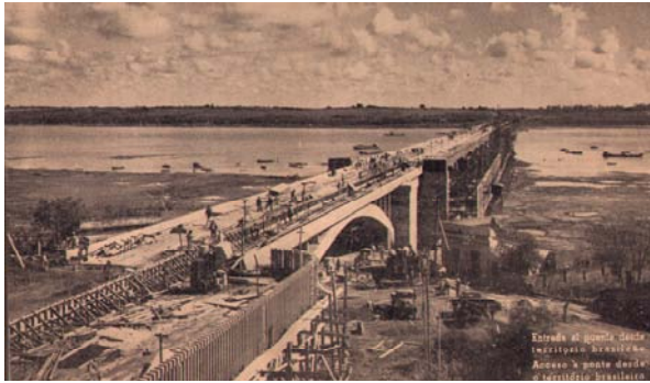
Imagem 25: Construção da ponte vista do lado brasileiro. Fonte: Ponte Agustín P. Justo/ Puente Getúlio Vargas, 1945. Pág.24
