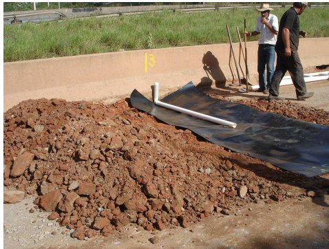
(a) Instalação dos drenos de PVC
