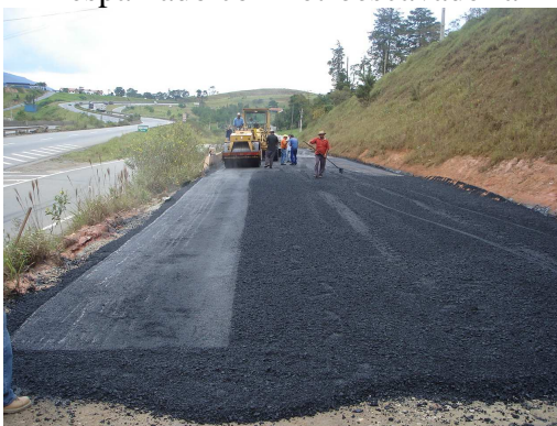
(e) Compactação do concreto asfáltico
