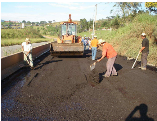
(c) Pré-misturado a frio (PMF), espalhado com retroscavadeira
