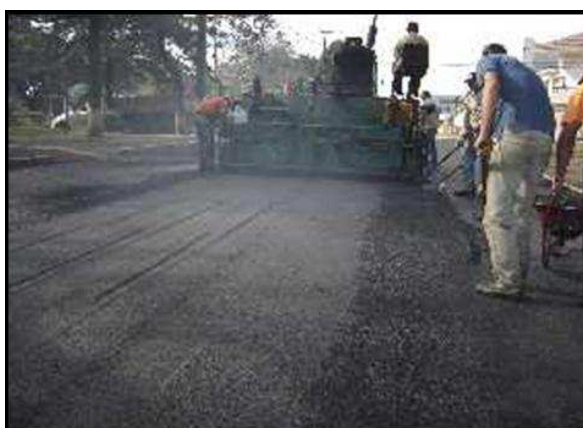
FIG. 2.6 Espalhamento e compactação de mistura asfáltica CA Fonte: http://www.prodesivo.com.br , capturado em maio/2007
