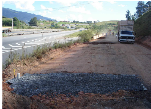
(b) Envolvamento do dreno com Brita n.º 1
