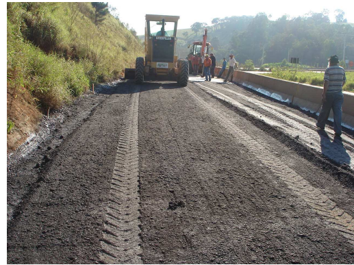
(b) Concreto asfáltico espalhado com moto niveladora
