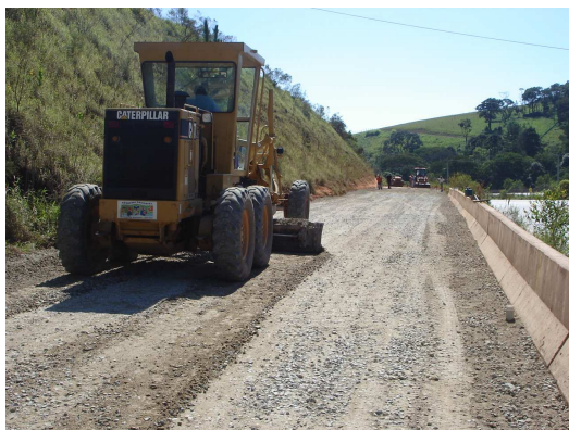
(a) lançamento do material de base tipo bica corrida
