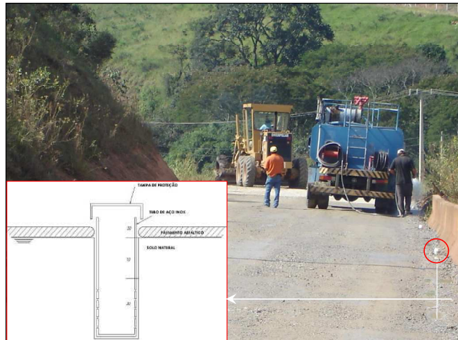
FIG. 3.20 Desenho do tubo coletor de água percolada
