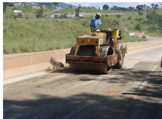
(b) compactação da base
