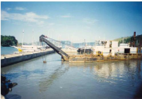
**Ilustração 45:** Dragagem de grande porte com escarificador elimina assoreamento e executa aterro hidráulico
