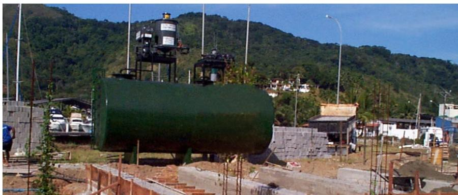
**Ilustração 64:** Tanque com filtros, ainda fora da caixa estanque
