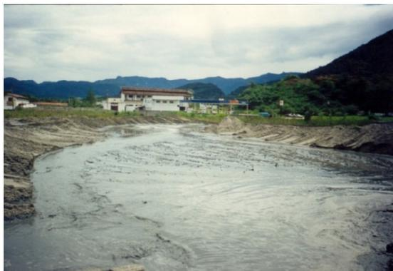
**Ilustração 49:** Alongamento do retorno da dragagem para reter os "materiais finos"
