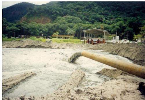
**Ilustração 48:** Aterro Hidráulico com material proveniente da Dragagem
