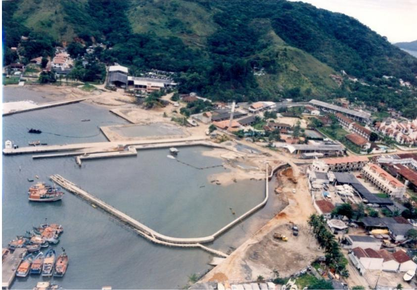
**Ilustração 44:** A Dársena da Golden Port em construção - internamente se vê a pequena draga mencionada, no quarto superior direito
