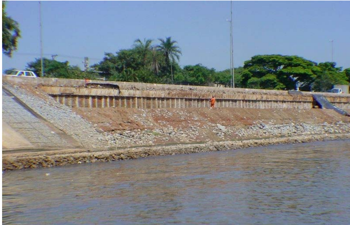
Figura 047 – Obras na calha do rio Tietê – Projeto Tietê Fase II
