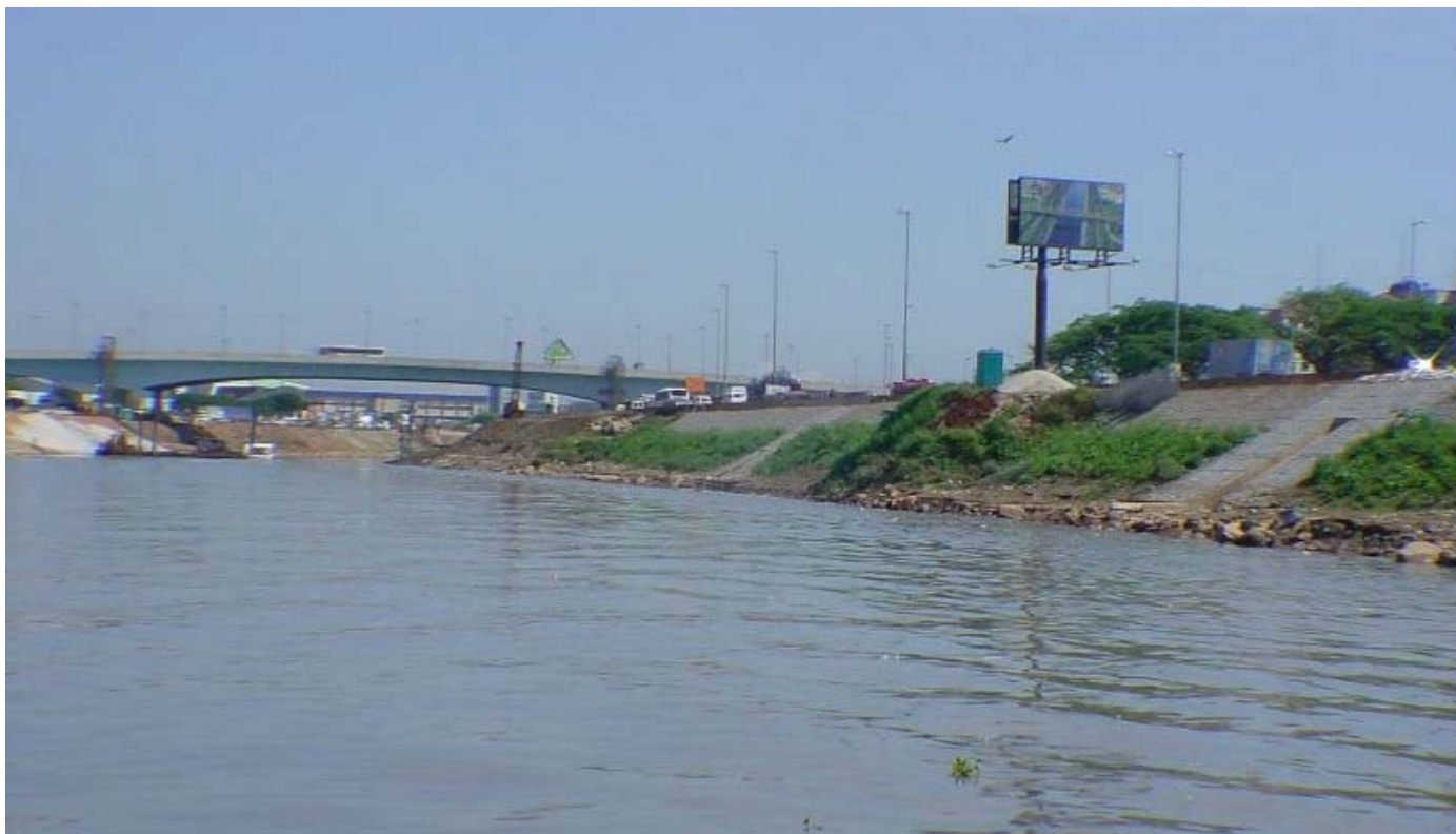
Figura 043 – Obras do Projeto Tietê Fase II – 2005
