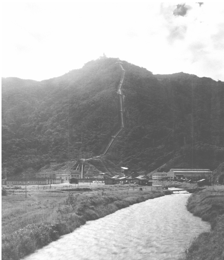
Figura 019 – Tubulação do Projeto Serra, até Cubatão – Vista Geral da Serra do Mar – 1940
