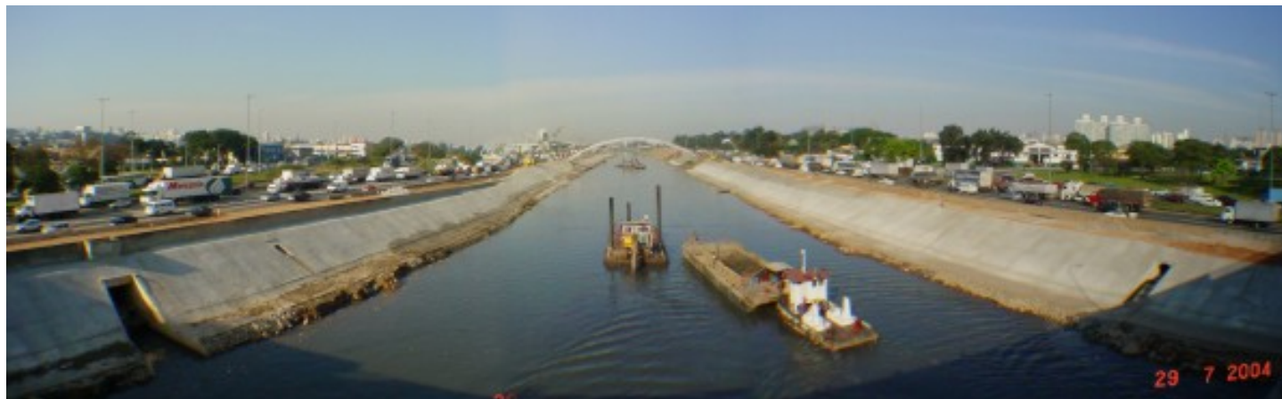
Figura 039 – Obra do Projeto Tiete Fase I – 2004
