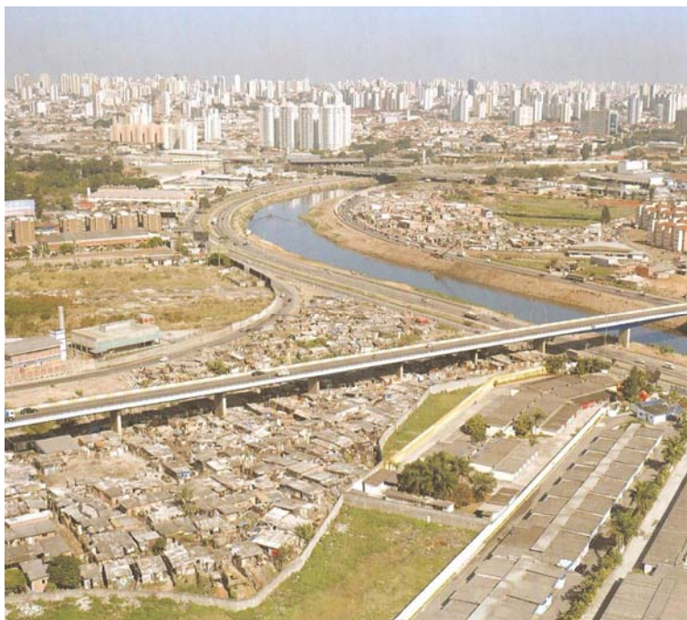
Figura 063 – Favela sob o Viaduto General Milton Tavares de Souza
