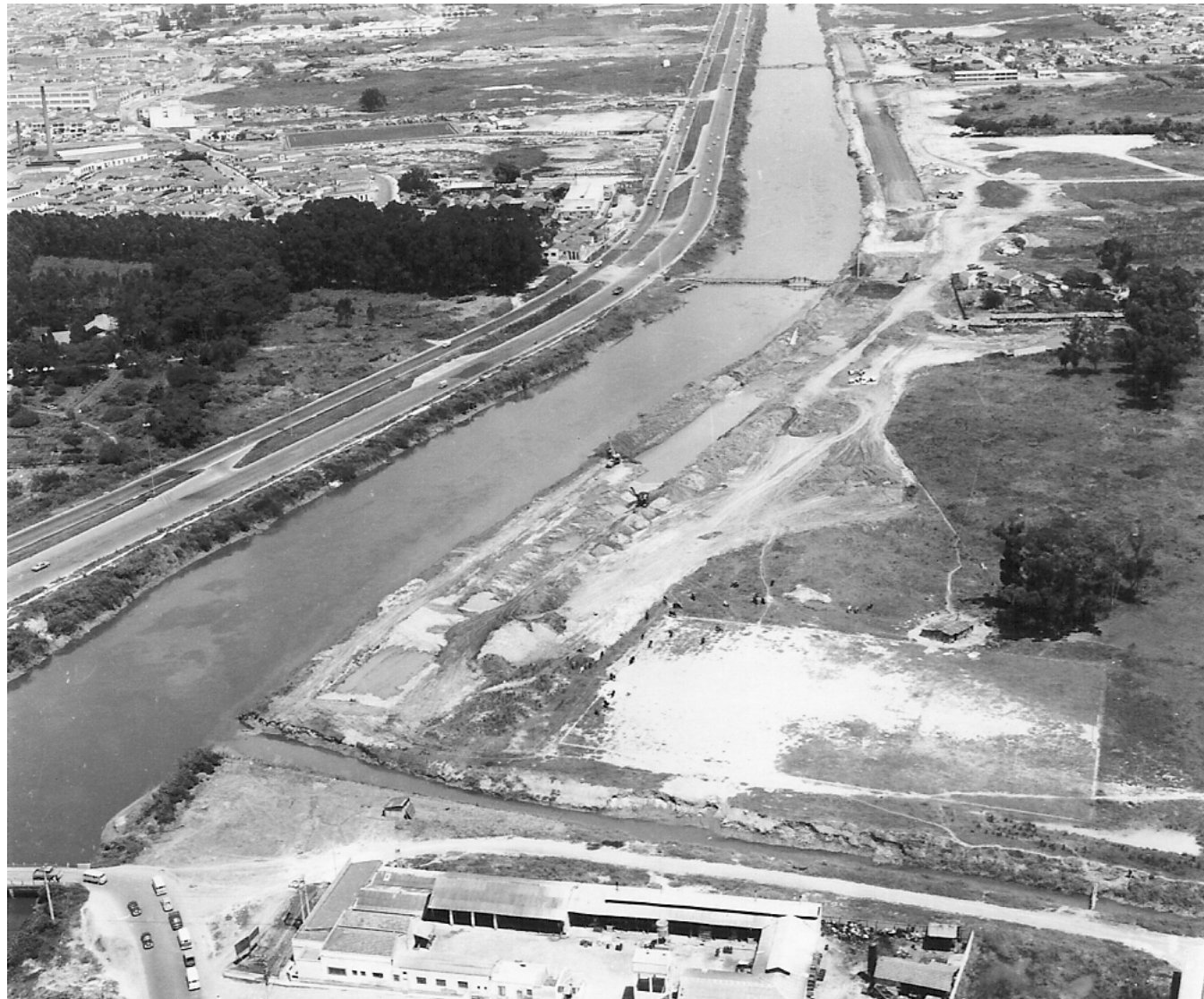
Figura 027 – O rio Tietê e as Obras das Vias Marginais
