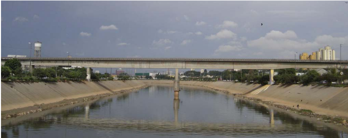
Figura 048 – Calha do rio Tietê Após as Obras do Projeto Tietê Fase II – 2007
