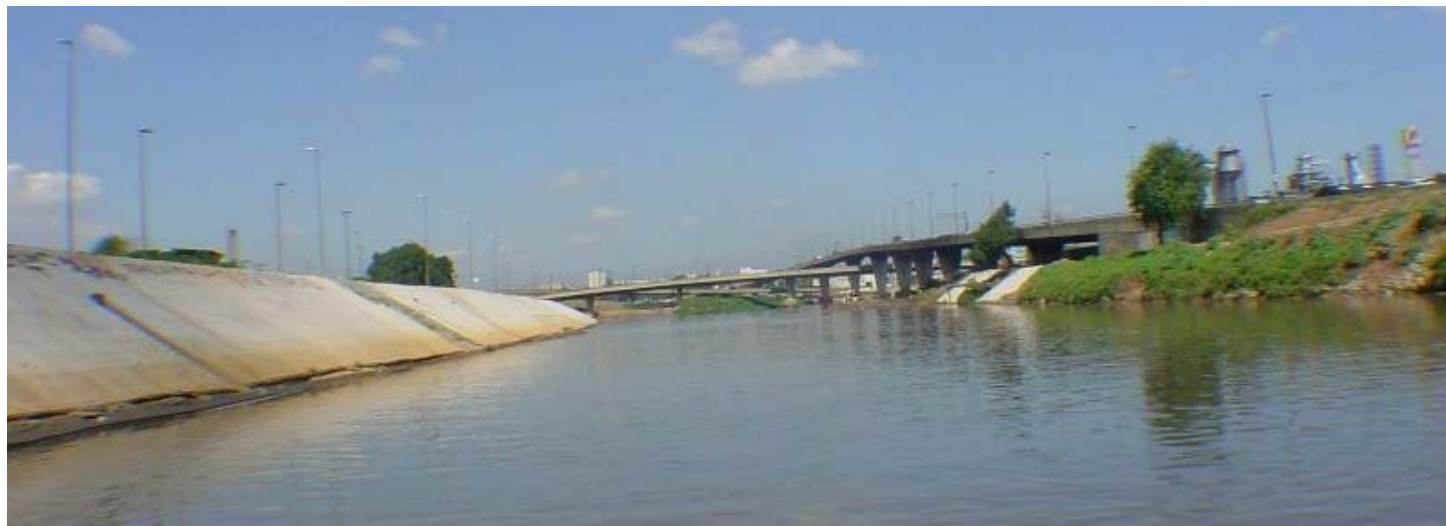
Figura 044 – Obras do Projeto Tietê Fase II – 2005
