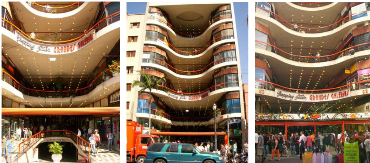
Galeria Grandes Galerias – Entrada Av. São João, entrada Av. São João e entrada Rua 24 de Maio Fotos: Autora, 2008
