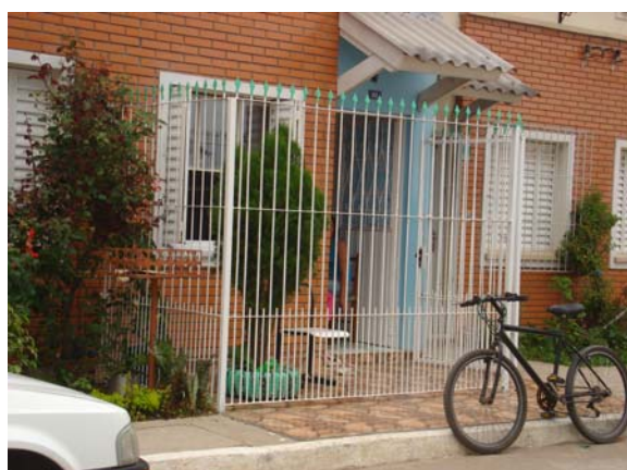
Figura 120 – Exemplo de acessório de proteção vertical (grade) e de revestimento cerâmico no piso realizado em UH do EHIS Pôr-do-Sol (11/2006)
