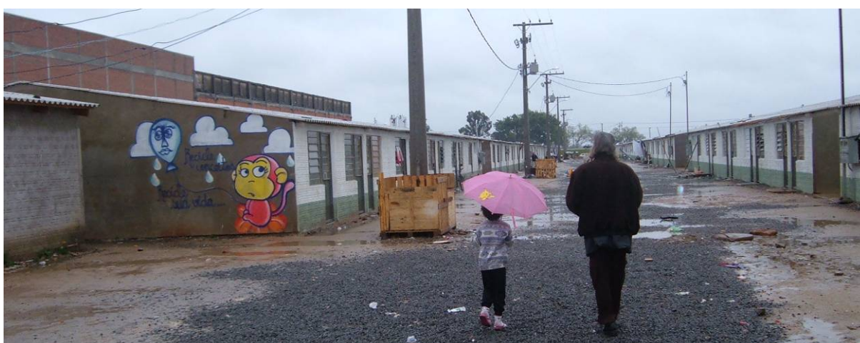
Figura 90 – Casas de Passagem ocupadas pelos moradores do extinto Assentamento Subnormal Vila dos Papeleiros em 09/2005, durante as obras do EHS Santa Terezinha
