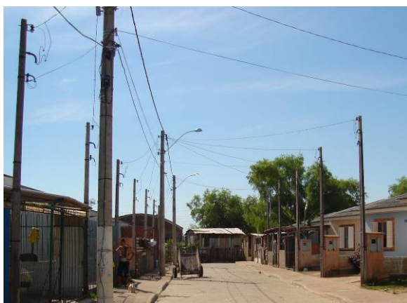
Figura 137 – Casas térreas do EHIS Progresso (11/2006)
