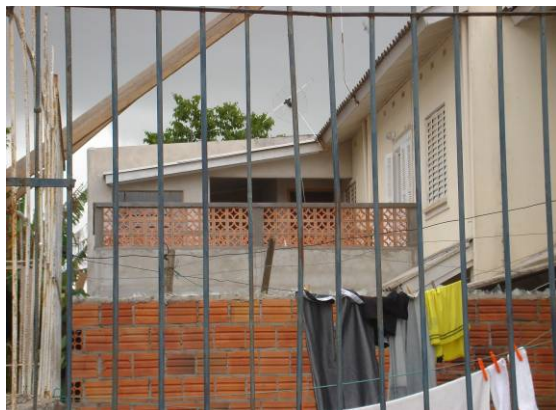
Figura 124 – Exemplo de ampliação realizada em pátio de UH do EHIS Pôr-do-Sol (11/2006)
