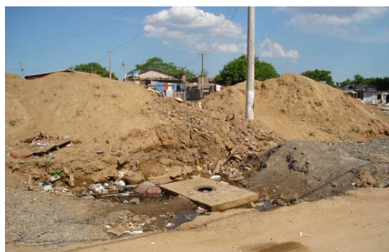
Figura 150 – Detalhe da infra-estrutura da Diretriz 607 em 11/2006
