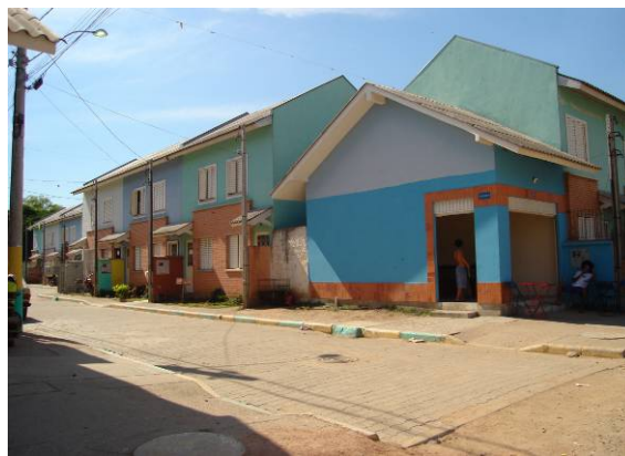
Figura 136 – Unidade Comercial do EHIS Progresso (11/2006)
