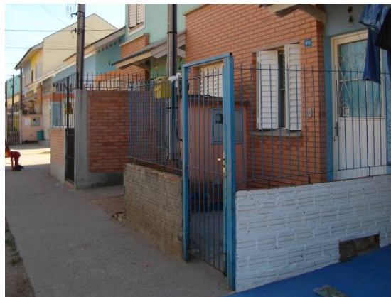
Figura 153 – Sobrados do EHIS Progresso localizados junto à diretriz 607 em 11/2006
