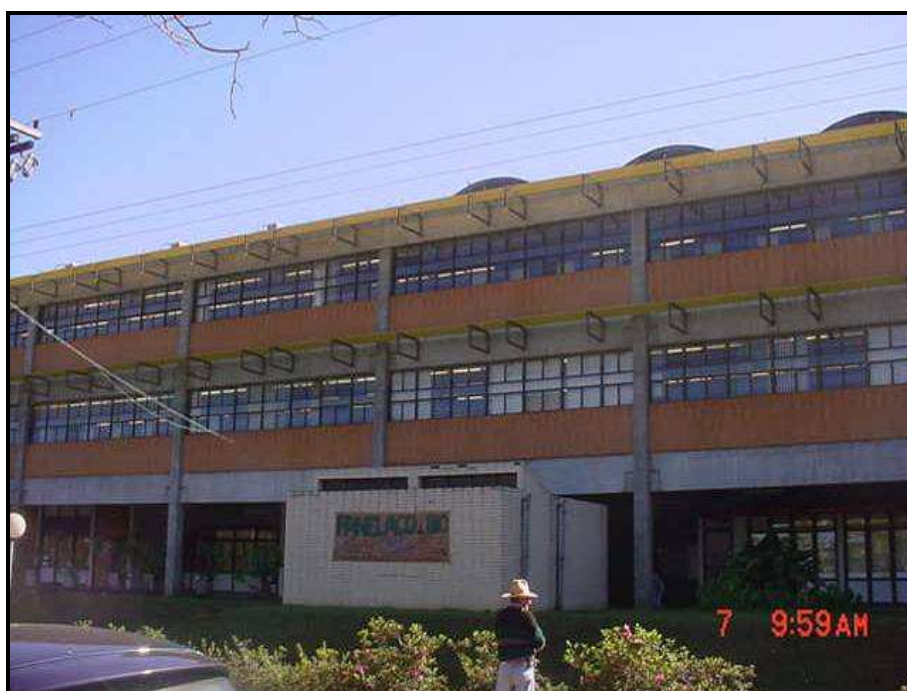
Figura 3.2. Vista da Biblioteca da UFSCar.
