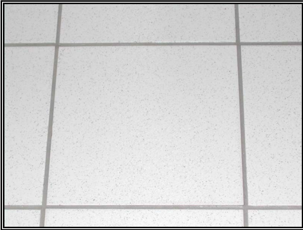
Figura 06- Detalhe do piso do laboratório
