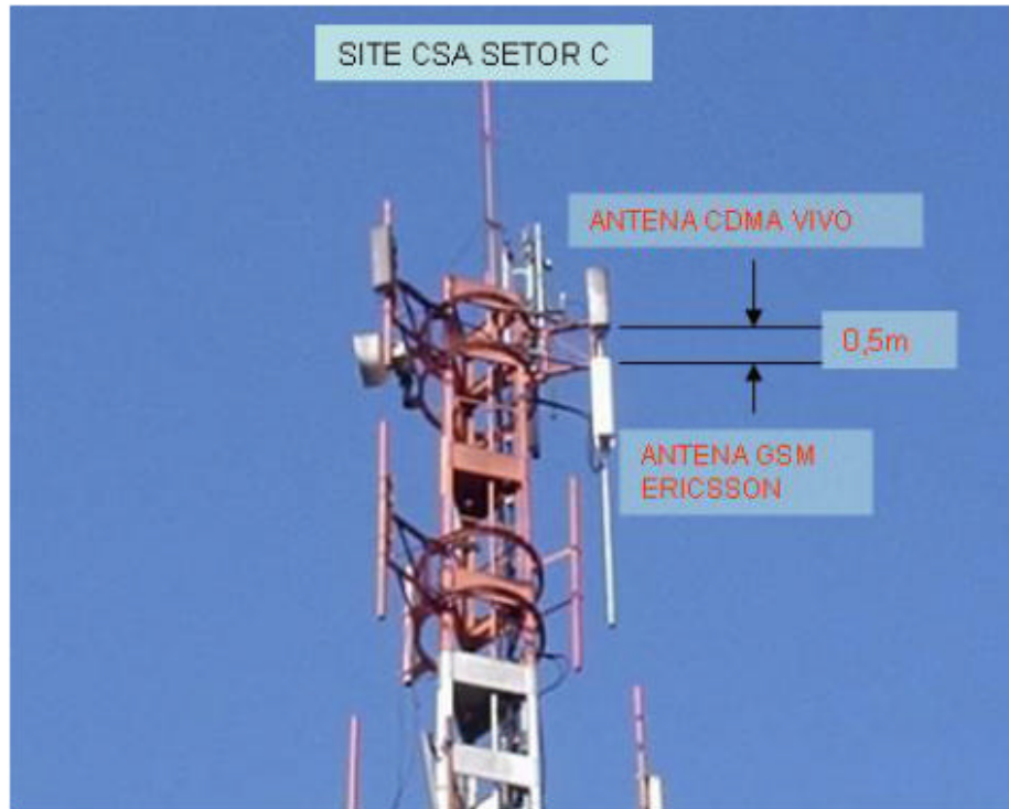
Figura 34 - Testes de Isolação entre Sistemas
