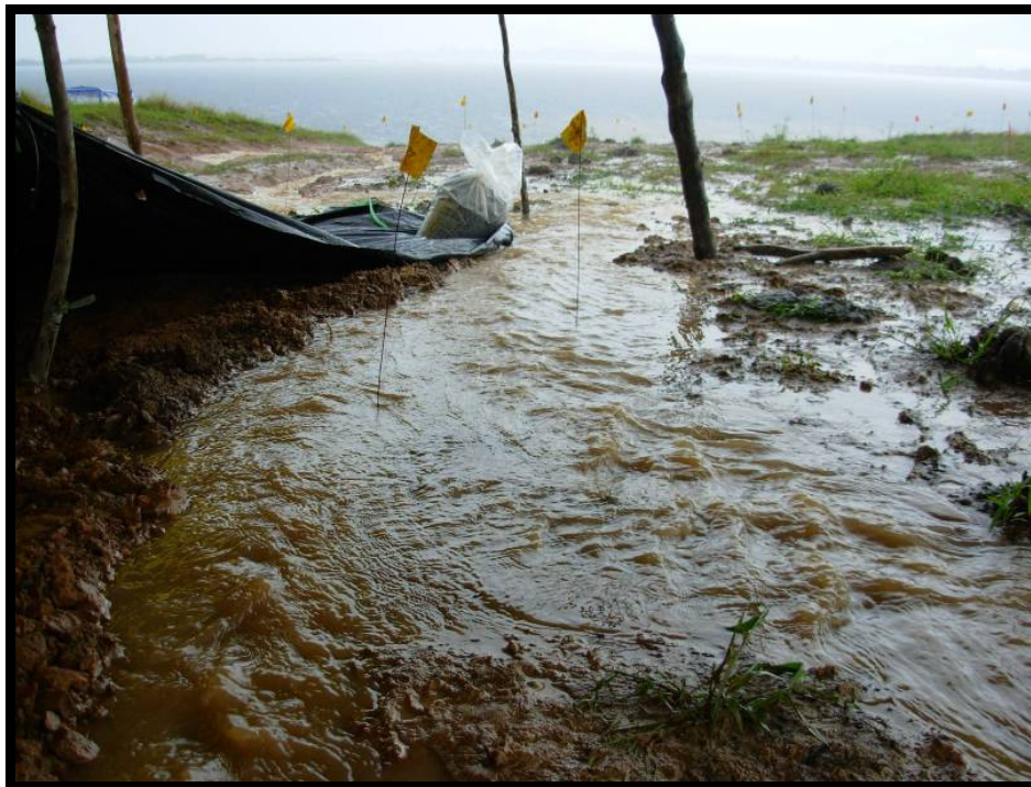
Figura 34 – Feições sinalizadas expostas à forte erosão pluvial (foto: Helena Lima).
