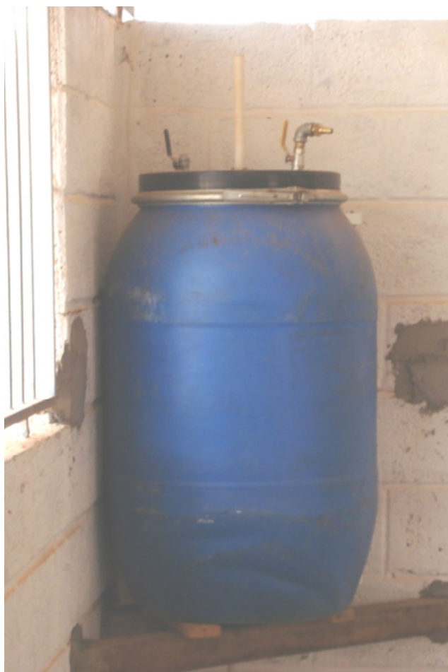
FIGURA 4 – Vista do reservatório de água utilizado nos ensaios.
