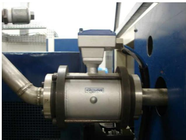
**Figura 26 - Medidor de Vazão Eletromagnético**
