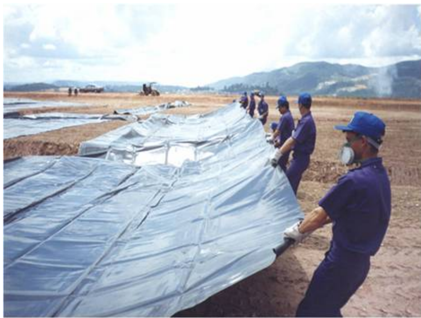
Figura 6 – Etapa de impermeabilização do terreno do futuro aterro sanitário. Foto do Aterro dos Bandeirantes – SP.
