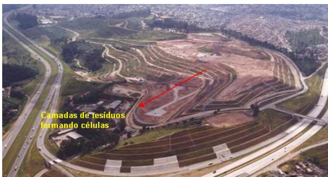
Figura 2 – Detalhe da etapa de cobertura e compactação do lixo no Aterro Sanitário dos Bandeirantes – SP.
