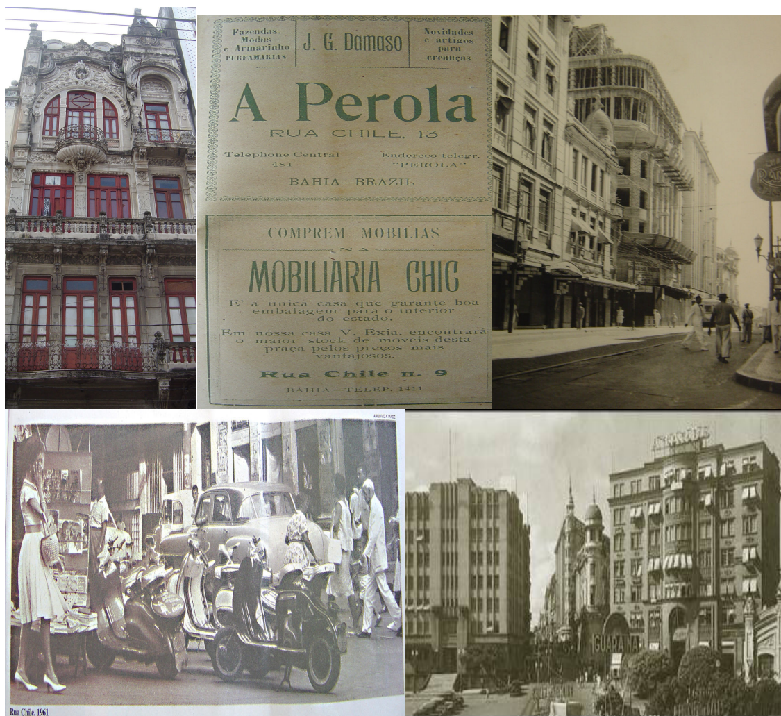
Figura 58 – Edifício de no. 08. Rua Chile. Figura 59 – Anúncio no Jornal de Notícias. Acervo da Biblioteca Central do Estado da Bahia. Figura 60 – Rua Chile. [193-]. Acervo da Coelba. Figura 61 – Rua Chile. [195-]. Acervo da Coelba.
