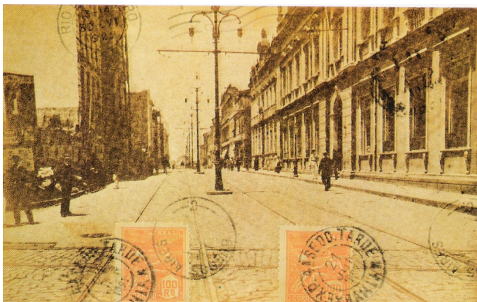
Figura 26 – Rua Chile depois do alargamento e com o imóvel de n. 2 demolido. Coleção Ewald Hackler.
