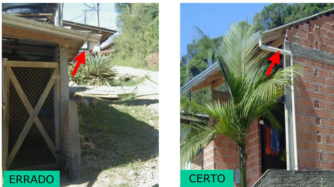
Figura 09 – Controle das Águas Pluviais
