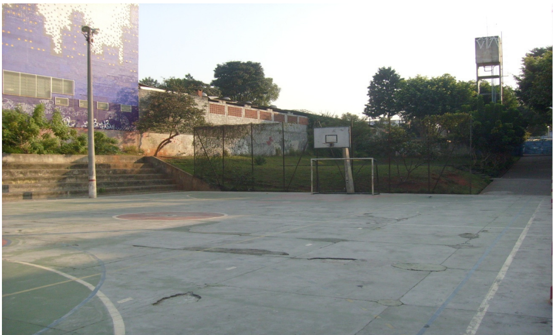
Figura 5: Vista da quadra poliesportiva
