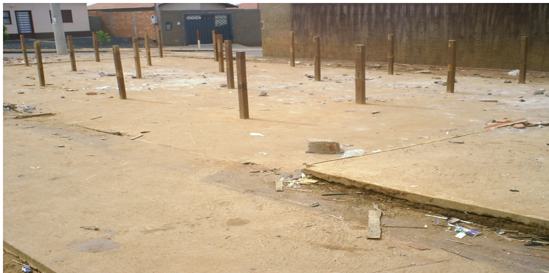
Figura 08 – Barracão: destruído e terreno e devolvido ao proprietário. Fonte: Arquivo Fotográfico da Autora
