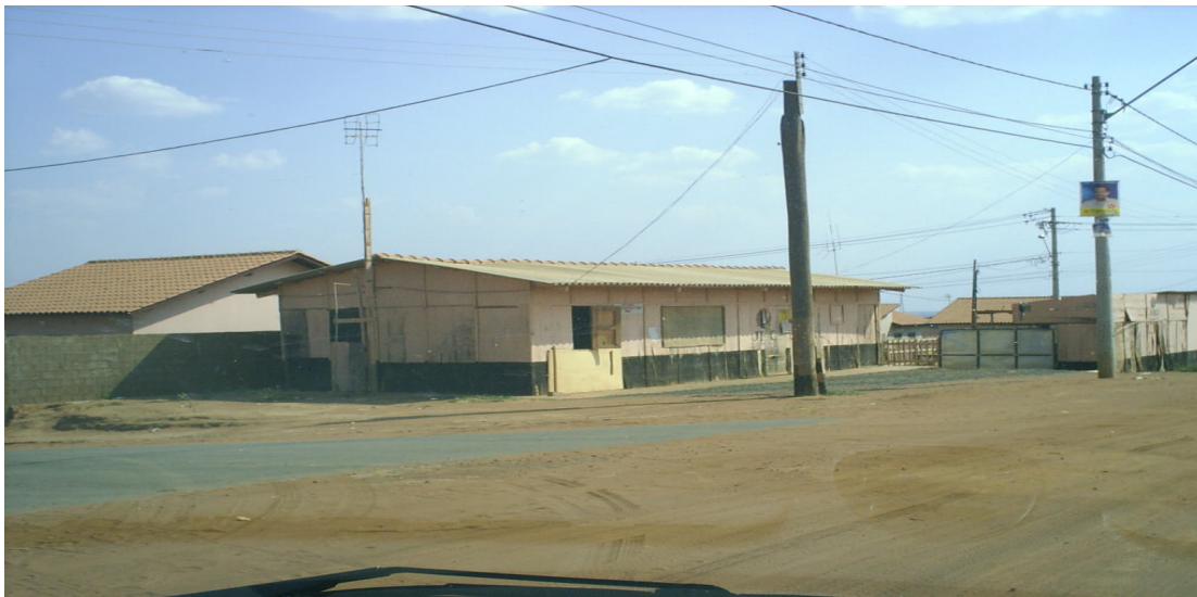
Figura 06 - O barracão cedido pela Construtora JHO para uso comunitário
