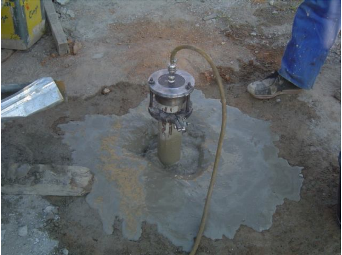
Figura 3.8 – Capacete e refluxo da calda pela bainha da estaca
