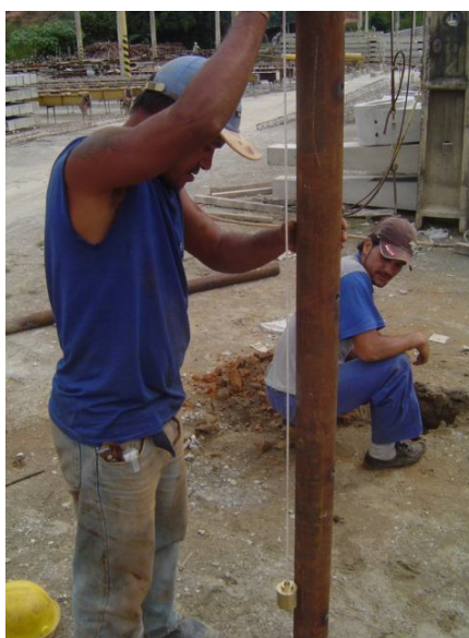
Figura 3.18 – Verificação da verticalidade do segmento adicionado à estaca
