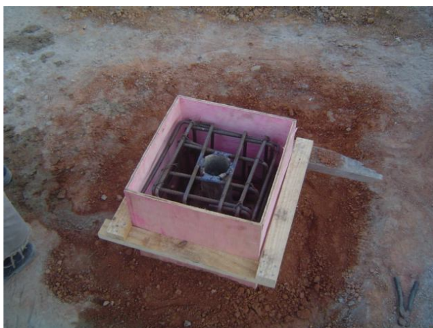
Figura 3.21 – Gaiola solidarizada ao tubo e forma para concretagem
