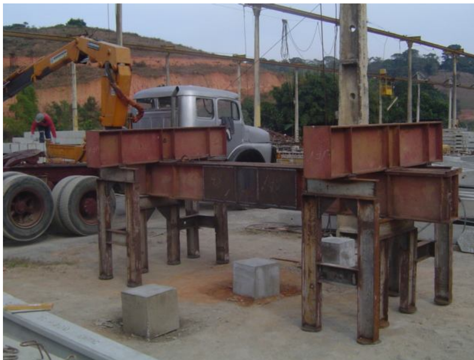
Figura 3.22 – Conjunto de vigas metálicas de reação
