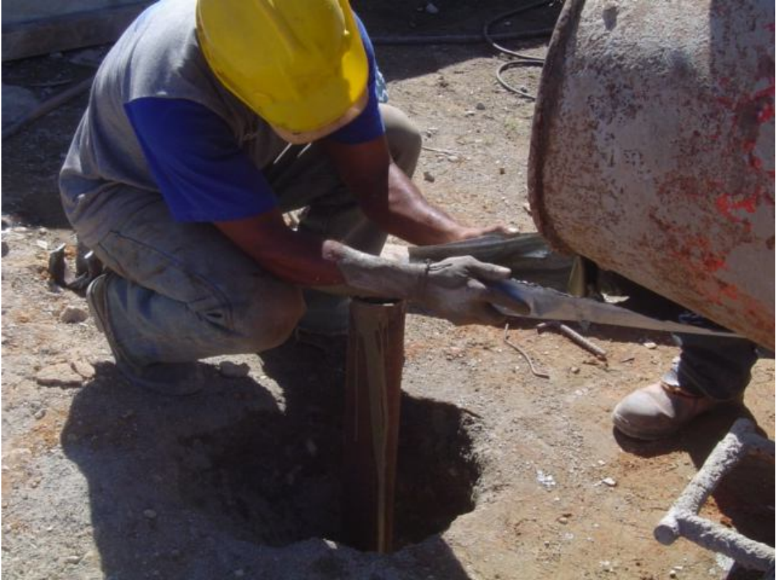
Figura 3.6 – Lançamento da calda preparada em betoneira
