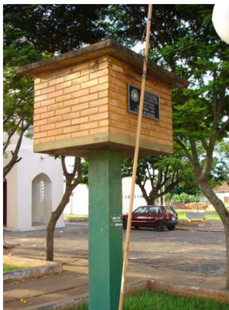
Fig. 7.2 - Estrutura na praça de Ouro Branco, distrito de Caiabú, onde há exibição de programas de TV para a população. Foto: Autor da pesquisa.
