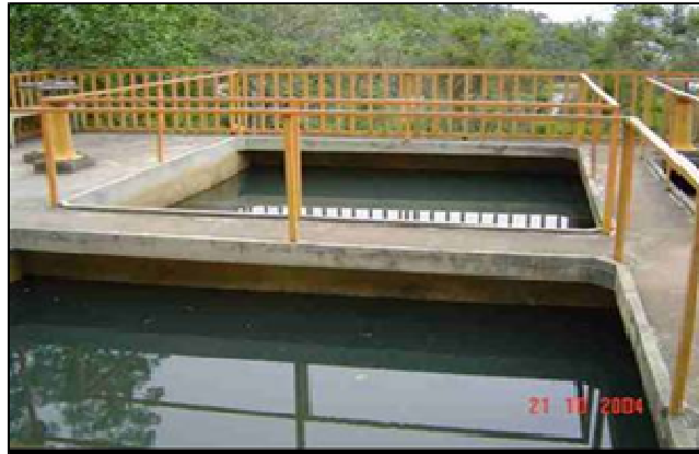
Figura 4.3: Vista dos filtros da ETA UFV
