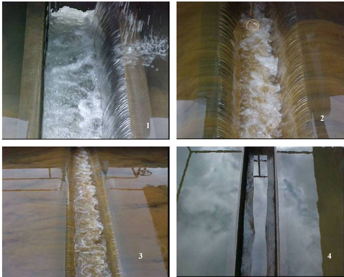
Figura 5.1: Etapas da lavagem dos filtros da ETA UFV: (1) início da operação; (2) após 2 min e detalhe da coleta de amostras; (3) após 3 - 5 min; (4) final da operação, após 8 – 10 min.
