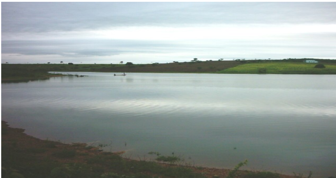
Fotografia 2: Vista parcial do Açude de Ribeirópolis-SE. (Wesley Lima)
