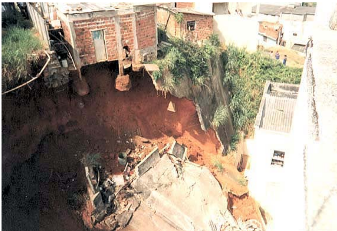
Figura 3.16 – Ruptura do morro do Gavazza (CODESAL, 2006).
