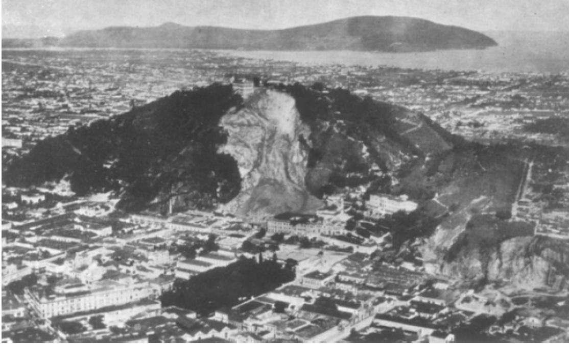
Figura 2.15 - Vista do Escorregamento de Monte Serrat ocorrido em 1928. (Vargas, 1999).
