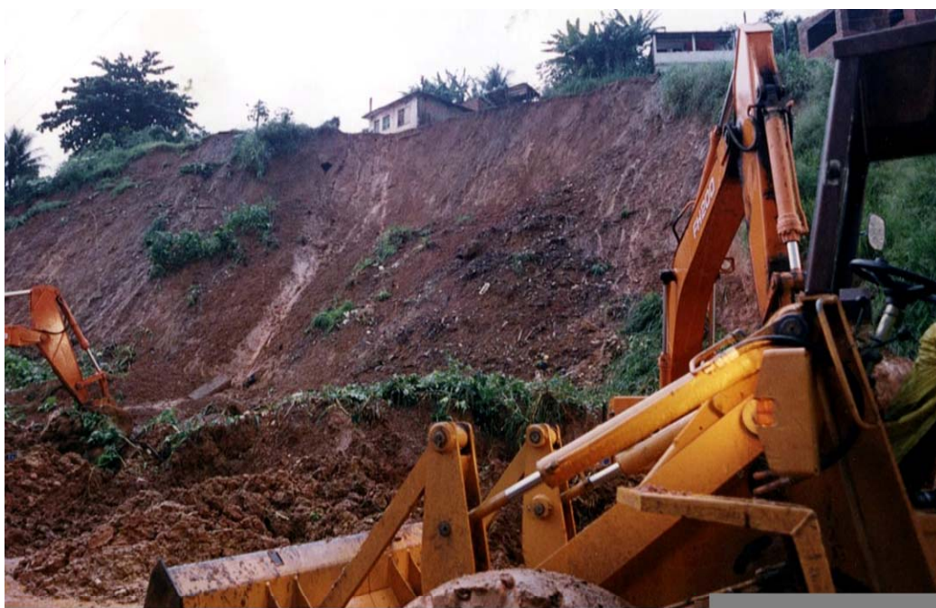
Figura 3.15 – Vista frontal do escorregamento da Avenida Suburbana.(CODESAL, 2006).
