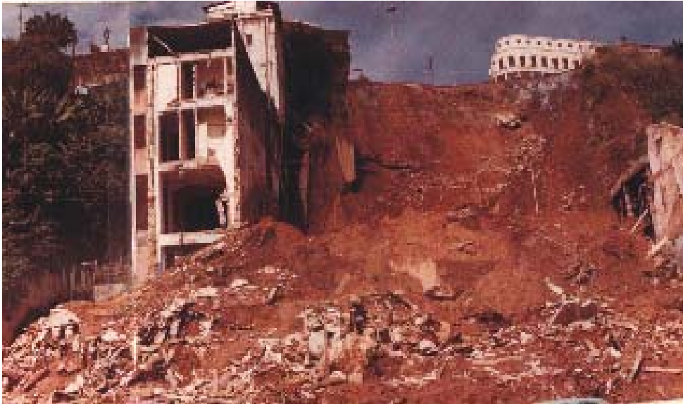
Figura 3.10 -Escorregamento do Maciço do Julião (CODESAL – 2006).
