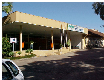
FOTO 2.4: Hospital Ana Nery na Rua Pereira da Cunha, integração global de 0,7875; movimento de pessoas com 34.590 atendimentos SUS em 2005
