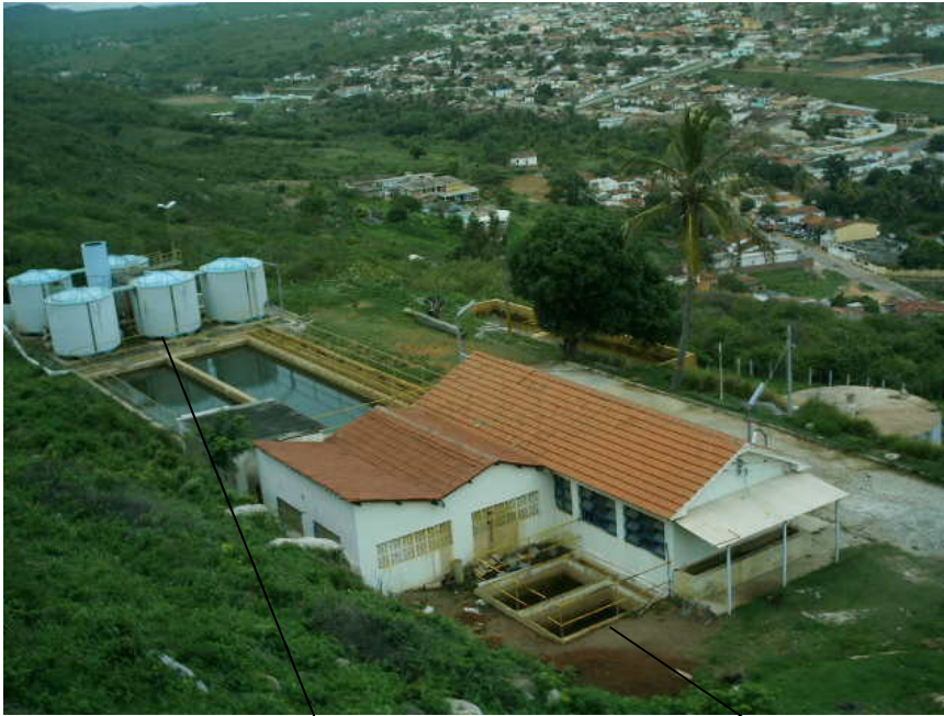
Figura 32 (a) – Vista da Estação de Tratamento – ETA de Pescaira
