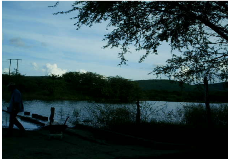
Figura 15 - Barragem “Passagem Molhada” – Distrito de Papagaio. Foto: S. S. Silva
