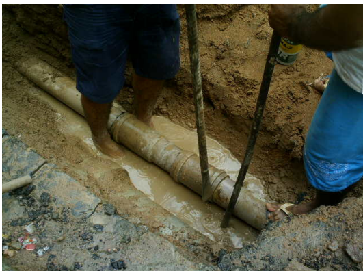
Figura 25 (a): Conserto de tubulação na Praça Dom José Nepote (PVC 110mm)
