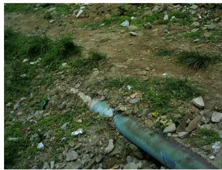
Figura 30 - Tubo de RPVC-DEFOFO (150 mm), Rua Bahia – Pitanga. Foto: S. S. Silva.
