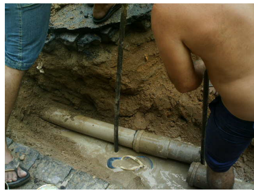
Figura 25 (b) Conserto de tubulação na Praça Dom José Nepote.
