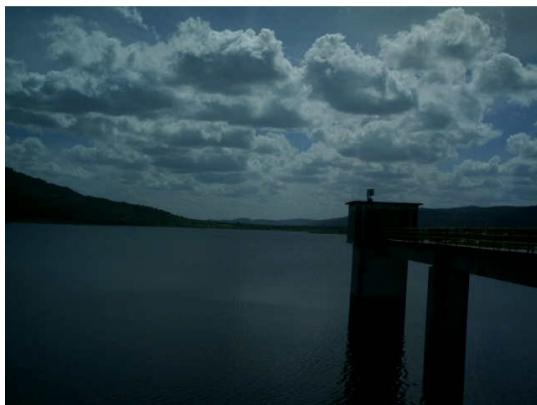
Figura 34 - Barragem Pão de Açúcar
