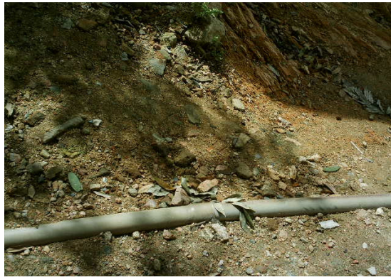
Figura 26 - Tubulação de PVC (60 mm) na Rua Severino Leite – Centenário.
