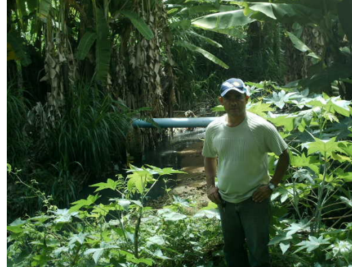
Figura 27 - Rede Principal do Centenário – RPVC DEFOFO (200 mm). Foto.: S. S. Silva
