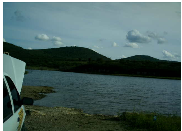
Figura 14 - Barragem da CISAGRO no distrito de Papagaio. Foto: S. S. Silva
