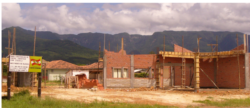
Figura 16 – Construção do Portal Turístico de Praia Grande.
