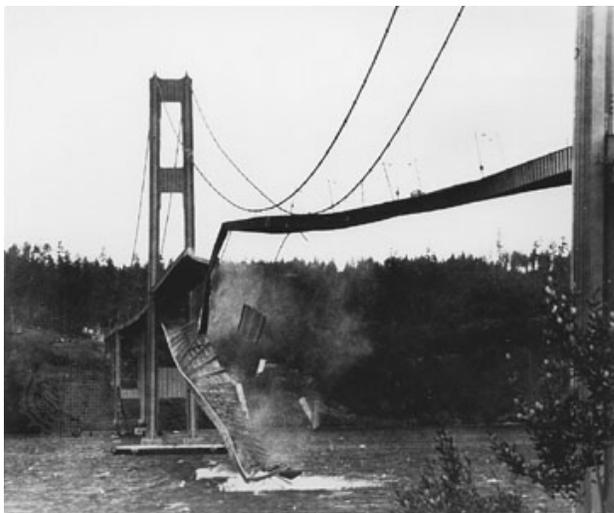
Figura 1.1 Colapso da ponte Tacoma Narrows
