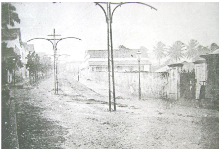
Foto 9 - “Observa-se já, a preparação dos postes...”. Manoel Dantas, referindo-se à chegada da luz elétrica. MIRANDA, João Maurício de. Evolução urbana de Natal em 400 anos .
