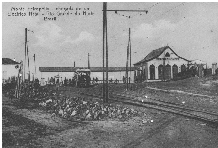
Foto 10 - Monte Petrópolis, situado em ponto alto da cidade e próximo ao mar. Além do bonde, se vê o “Café Petrópolis, à direita da imagem. Nessa região foi construído o prédio que abrigaria o Hospital Juvino Barreto. Foto: Natal ontem e hoje (cd).
