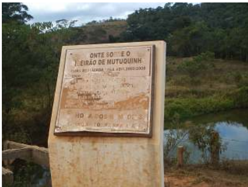
FIGURA 14 – Ponte sobre o Ribeirão da Mutuquinha
