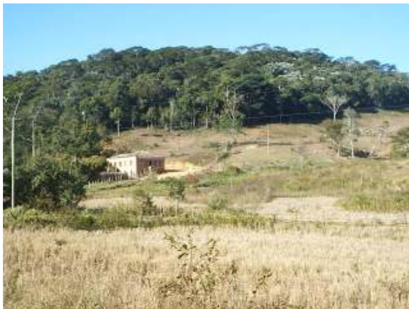
FIGURA 21 – Casa em condição de risco.
