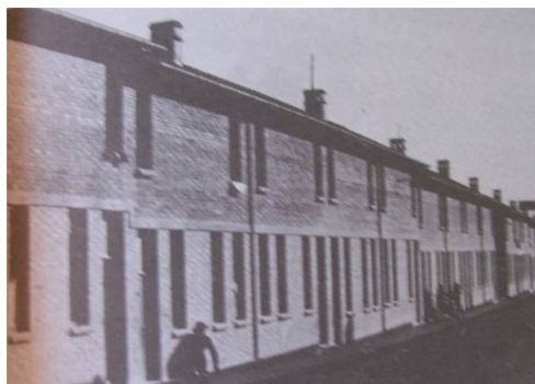
Figura 3: Vila Boyes destinada à operários.
