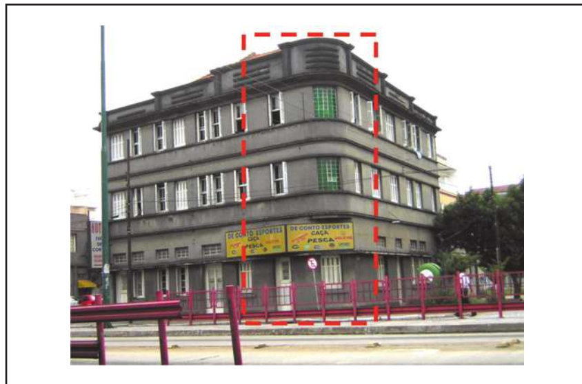
Figura 6.113 Valorização das esquinas. Fonte: O autor
