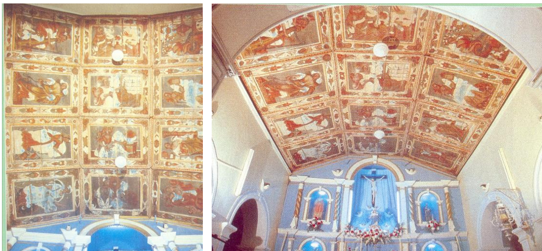
Ilustração 41 – Forro da Igreja Matriz de Viçosa - CE
