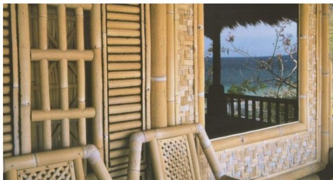
Figura 37: Fachada com diversas técnicas de vedação em bambu.
