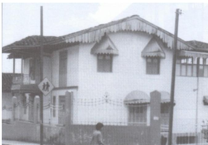
Figura 41: Antiga construção de bambu em bom estado de conservação.
