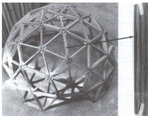
Figura 48: Estrutura geodésica em bambu laminado e a peça laminada que a compõe.
