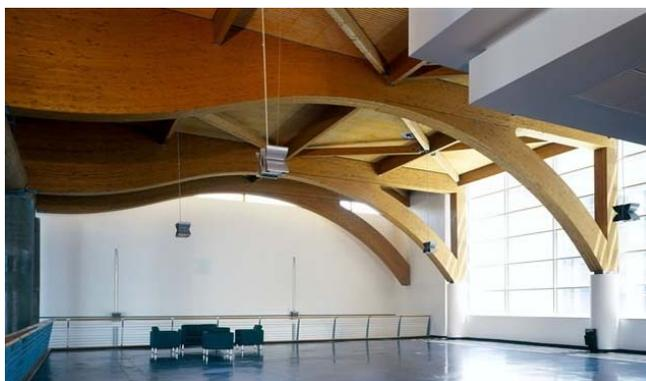
Figura 43: Vigas laminadas de madeira.
